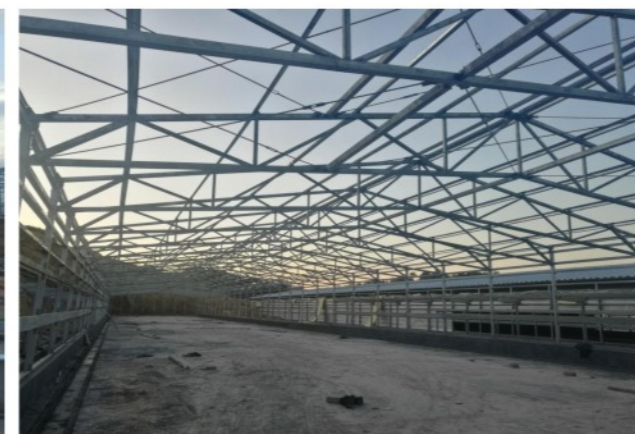
桁架结构鸡舍
